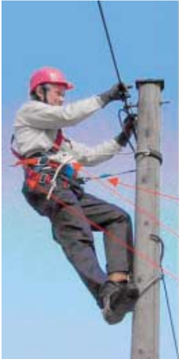
Bild 4: Arbeitsplatzpositionierung an einem Mast durch einen Auffanggurt mit integrierter Haltefunktion
