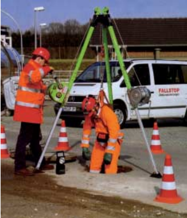
Bild 18: Rettung aus einem Schacht
