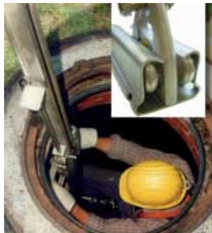
Bild 9: Steigleiter mit Mittelholm, Steigschutzeinrichtung und steckbarer Haltevorrichtung
